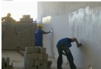
Foto 1 - Emassamento de parede
