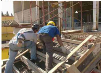
Foto 2 - Execução de formas e armadura da escada.
